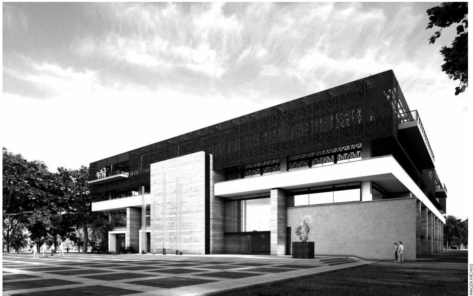
La obra completa de 12 mil metros cuadrados finaliza en 2021.
